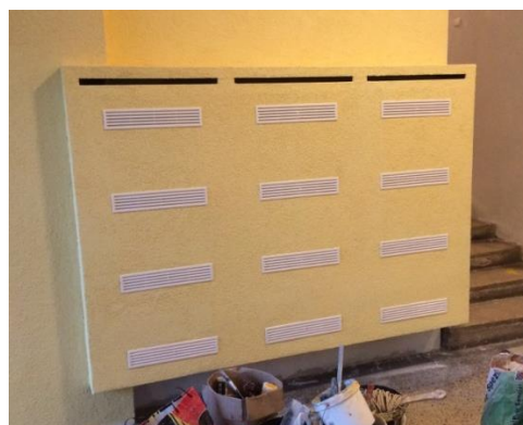
2.15.attēls: Siltummezgls, vecais čuguma radiators tika iestrādāts dekoratīvajā kārbā
